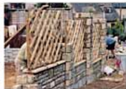
街で見かけたEX工事、石組にウッドフェンスが映える
