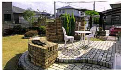
門から右手に続くガーデン（1期工事）
