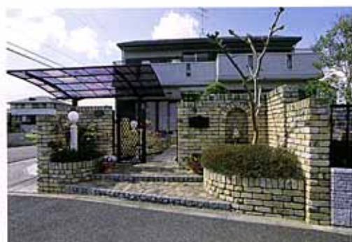
1期・2期工事を経た門まわり
