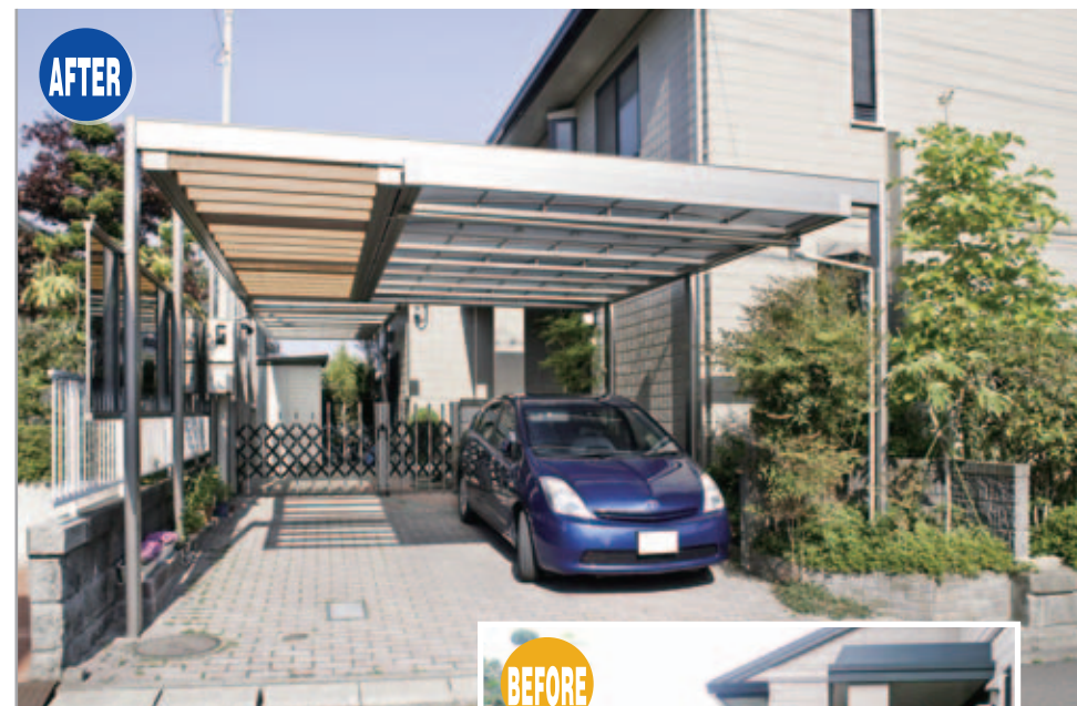
【エクステリア全景】 奥の塀を取りはらい、カースペースを手前に2台、奥に1台分確保。敷地と建物の形に合わせてUスタイルをL字に設置しました。屋根の一部をパーゴラ仕様にしたので、爽やかなアプローチにも。
