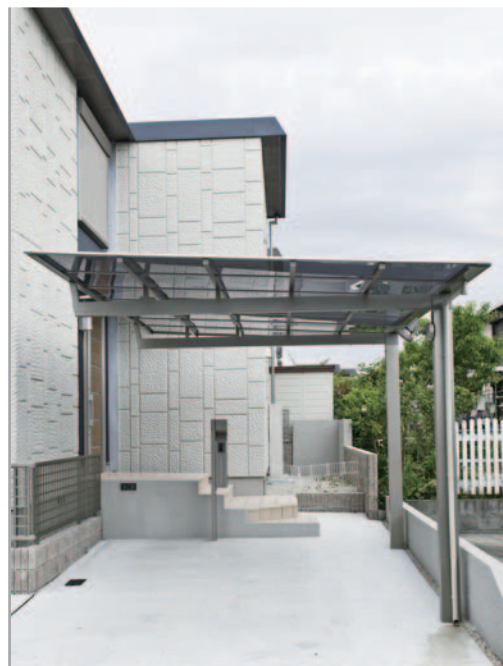
【カーベース兼アプローチ】 アプローチに設置したフラットなマイリッシュカーポートは、シンプルモダンな外観にぴったり。機能ボールもマイリッシュ。
