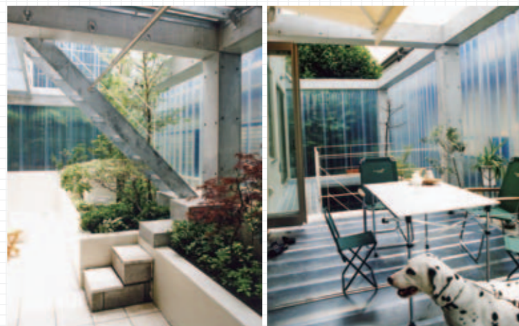
2階テラスの床が光を透過するため、その下はこんなに明るい。雨に濡れないので洗濯物干し場として重宝。
