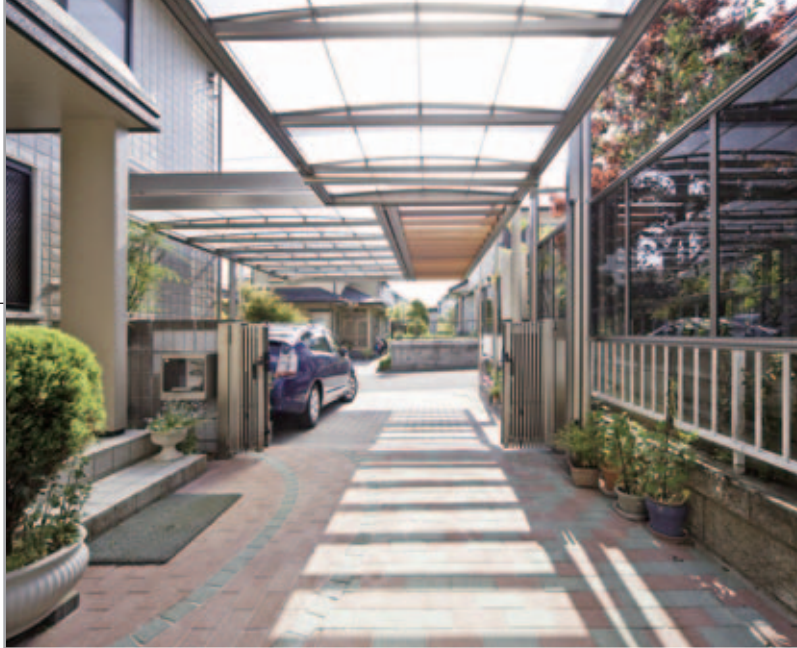
【奥から道路を見る】 以前は鉢がたくさん置かれていた場所を整えて1台分のカースペースに。床材は透水性のブロックを使ったので、雨の日でも足元すっきり。
