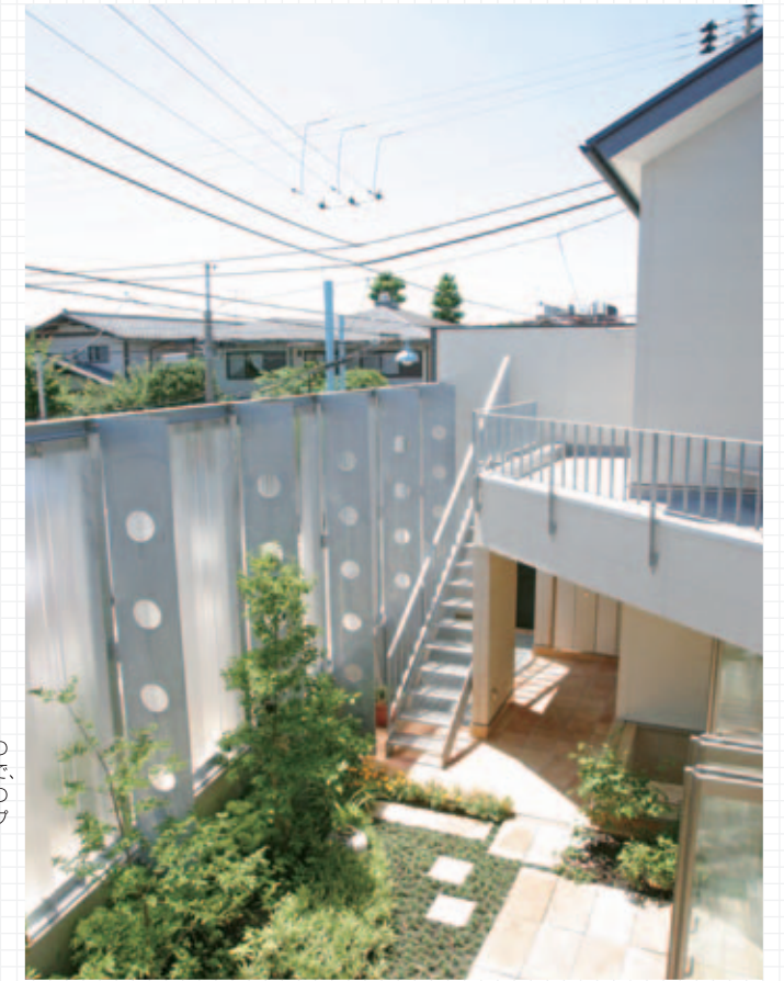
高さ4mのポリカーボネートの塀を巡らして敷地を囲ったので、明るさはそのままに、まわりの視線を気にせずにくつろげるプライベートガーデンが完成。
