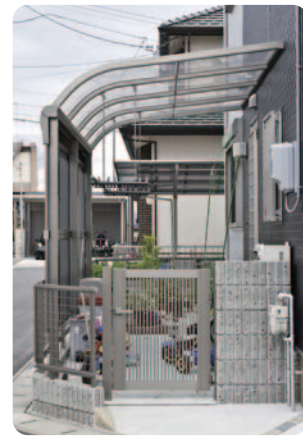
【勝手口に屋根】 勝手口にはグッドエパーで屋根を設け、子どもたちの駐輪や物干しなどに活用。側面パネルは道路からの視線を遮るため。扉はカムフィの門扉。
