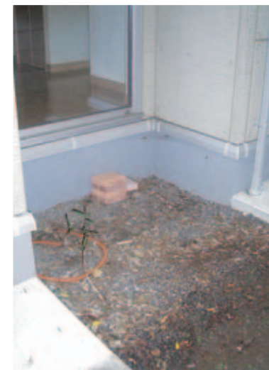
左、屋外から撮影した坪庭スペースの写真
