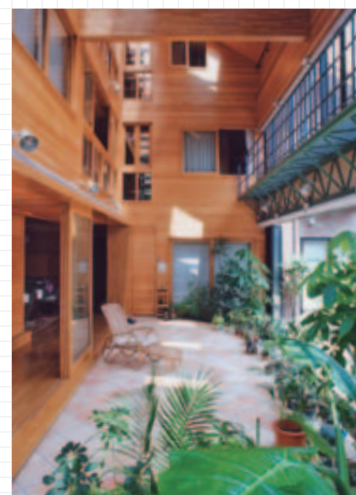
三層を風が吹き抜ける爽やかなインナーテラス空間。2階のトラス梁の上はグレーチングの床板が設置され、窓掃除用のキャッツウォークに。
