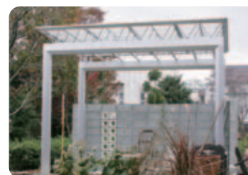
庭の奥にはM.シェードが。まだ工事中なので完成が楽しみです。
