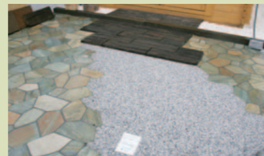
ログハウスの相談ルーム前の床もさまざまな素材で表情豊か。枕木に見えるのはコンクリート製の擬木です。
