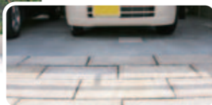
【すべらない床材】 北向きで冬場は雪が溶けにくいので、できるだけすべりにくい床材をと配慮して、ゴツゴツした御影石を使用。
