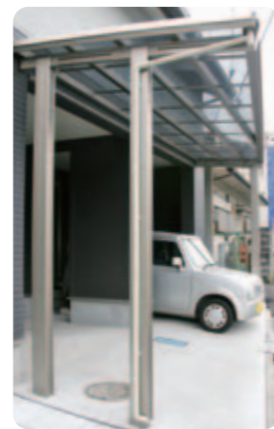
【ルーフ+ガレージ】 建物の前の敷地は台形になっています。その形状に合わせてルーフフェスのルーフを台形に加工。境界線までぴったりと納めています。左側の柱が前に出ないため、車の出し入れがしやすいと好評。
