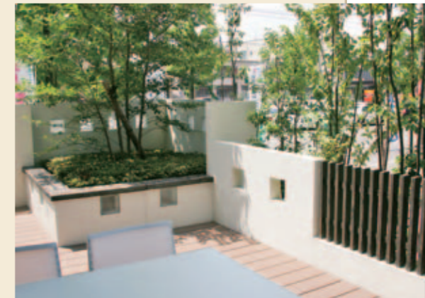
【リビングデッキ】 リビングの窓の外には、ひとつと木でデッキをL字にまわし、テーブルを置いてアウトドアの団楽の場に。縦格子と塀の組み合わせで、開放感を保ちながら外の視線を遮断。
