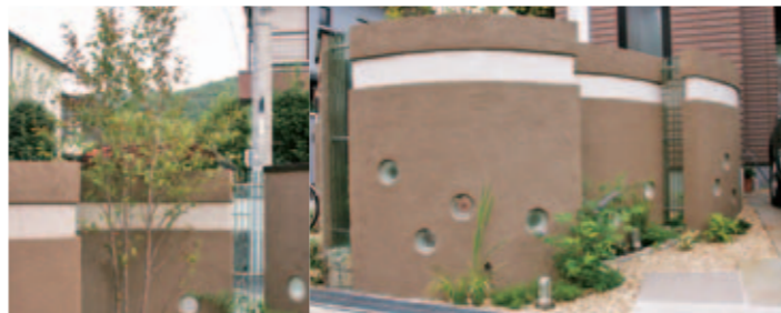
【アールのついた塀】 駐車場とアプローチを曲線の塀で柔らかく仕切りつつ、丸型ガラスブロックやスリットで閉鎖的にならないように工夫。塀の足元の花壇は、野草が自然に生えたようなイメージに演出。
