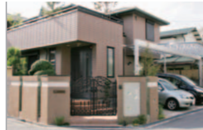
【エクステリア全景】 左側に少し見える塀は既存のまま、門まわりとカースペースをリフォーム。門扉も既存。古い部分と新しい部分が違和感なく調和。
