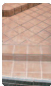
【床タイルの心遣い】 アプローチは既存のタイルを生かし、手前のステップ部分だけ新しいタイルを使用。違和感なくつなげるのに苦労したそうですが、予算をできるだけ抑える心遣い。
