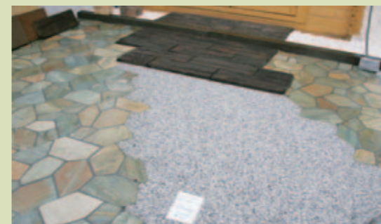
ログハウスの相談ルーム前の床もさまざまな素材で表情豊か。枕木に見えるのはコンクリート製の擬木です。
