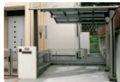
【2つの入り口】 カーポートの奥にもう一つ門扉を設置。車から降りて、買い物荷物をここから奥の勝手口へ運べるので便利です。門扉はメッシュフェンスとハンヨウ型材を使って現場施工。
