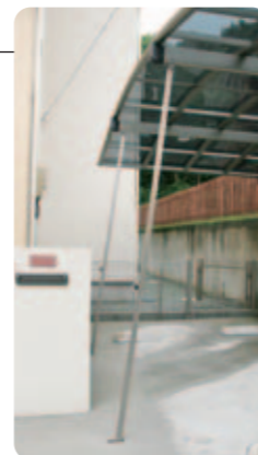
【着脱サポート柱】 カーポートは片支持なので、強風の場合など屋根が煽られないように、着脱式のサポート柱が付けられます。
