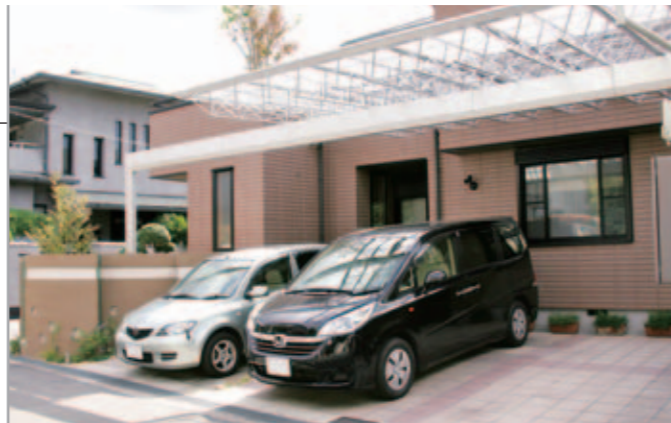
【M.シェードのカースペース】 駐車スペースにはM.シェードを設置。片方の梁を延ばしたので、邪魔な柱もなく、スペースを広く使えるし車の出し入れもスムーズに。明るさと開放感も好評です。
