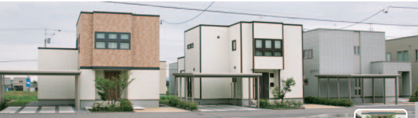
[エクステリア全景] 隣合う3棟の住宅に、それぞれツインZを設置。直線的なラインとアーバングレーの色調が、シンプルモダンの建物に美しく調和しています。
