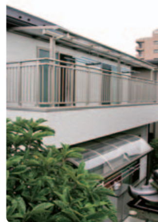
【テラス屋根】 庭側のテラスには、上下階ともテラス屋根・グッドエバーを設置。アーバングレーの色調が手すりや窓枠とも合って、建物に自然に溶け込んでいます。これだけ屋根があれば、洗濯物を干したまま外出しても安心です。
