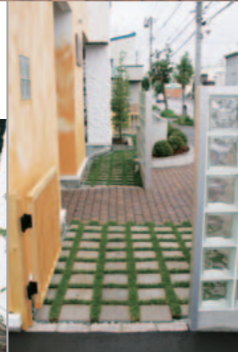
[左端から見る] 角芝平板の床が美しい。レンガもオーナーの希望で隙間をあけて敷いたので、いずれ間に草が生え、より風合いのある床面に。
