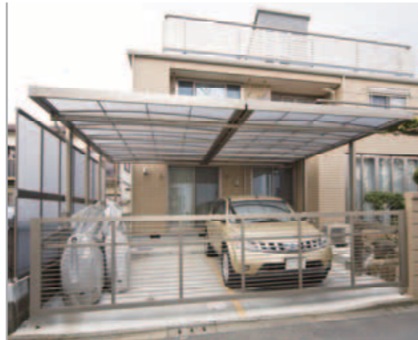
【庭側のカーポート】 U.スタイルで2台分の駐車場を確保。フラット屋根が建物のデザインと調和しています。跳ね上げ門扉も設置したので安心。隣家との境には側面パネルをつけて目隠しに。
