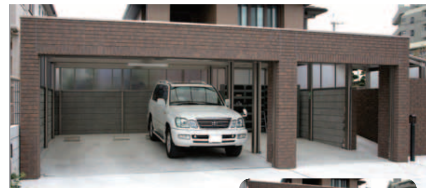
【3台用シャッターゲート】 この3台用の電動シャッターゲートバレオは特注仕様。右側には玄関に通じる出入り口を設けました。
