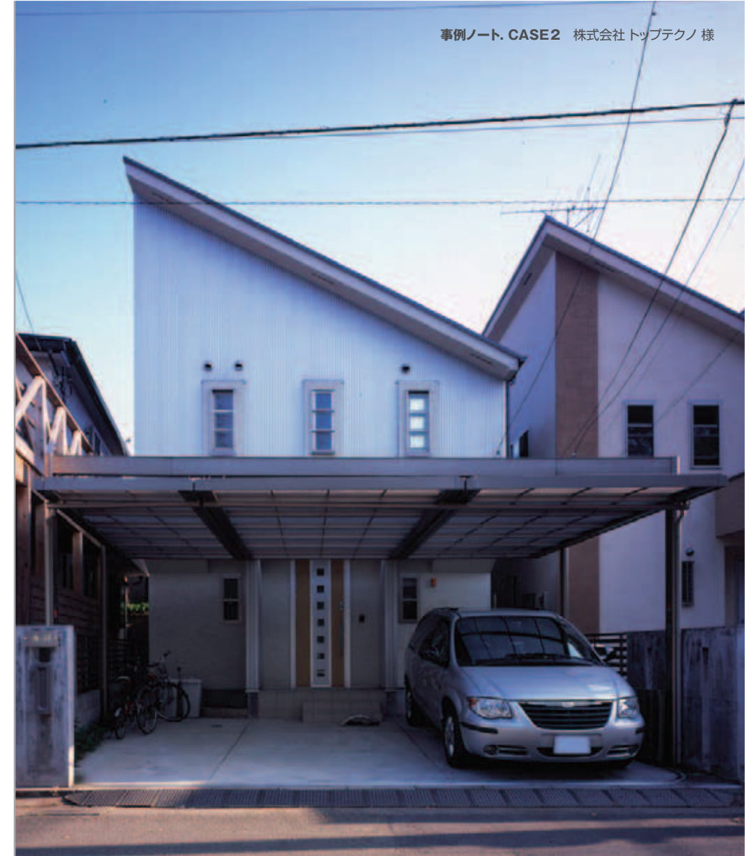
【エクステリア全景】 片流れ屋根のシンプルモダン住宅に、シャープなラインのUスタイルのカーポートがぴったりと調和。色調もグレイッシュに統一され、シックな外観に。
