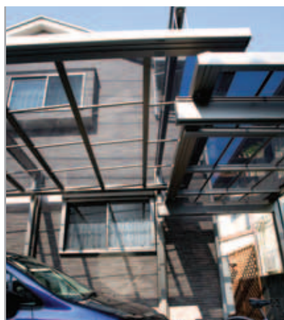
【窓をよけ、段差をつけた屋根】 建物の窓をよけてプランできたのは、柱の位置や高さを自由に調節できるUスタイルならでは。カーポートの屋根は窓に合わせて高く、サイクルポートの屋根は低く、2つの屋根に段差をつけて巧みにつなげています。
