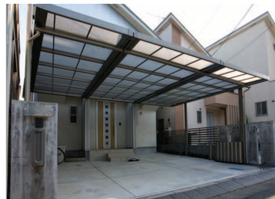
【カーポート兼アプローチ】 敷地の隅から隅まで、Uスタイルの大屋根で覆っています。間に柱がないので、スペースを広く使え、カーポートにもアプローチにも。車から玄関まで雨に濡れないのも好評。
