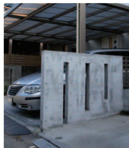
【コンクリートの塀】 隣家との境にはコンクリートの塀を設置。スリットを入れたことで、重くなりすぎず、さりげなく目隠しを。
