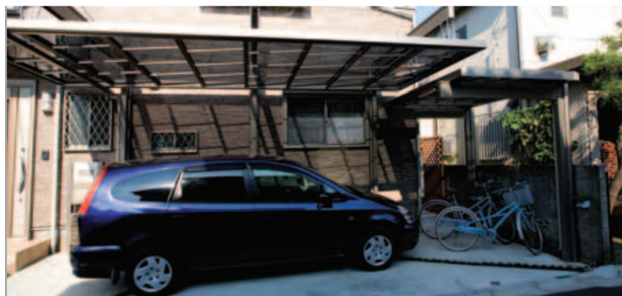
【片側支持のカーポート】 Uスタイルは片側支持にしたので柱が少なく、限られたスペースを広く使えます。カーポート部分の屋根は吊り下げタイプ、自転車用の屋根は梁置きタイプに。
