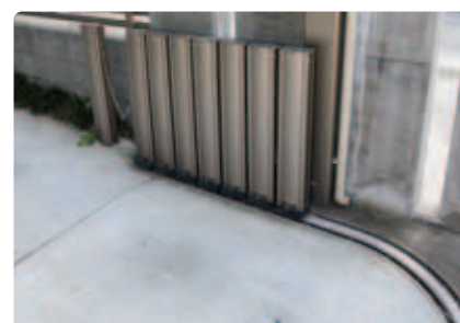
【ボールゲート】 前面にはスライド式のボールゲートK2型を設置。ゲートを畳むとこのように右側に集まります。
