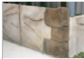
【スタンプコンクリートを壁面に】駐車場の壁面の「石」は本物ではなく、スタンプコンクリートを使って経済的に。
