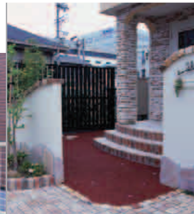
【玄関アプローチ】 正面からでなく、右ナメから入るようにしてあります。エンジ色の床はゴムチップを敷き詰めしたもの。踏み心地が柔らかく、すべりにくいと好評です。ハッキリした色使いが、玄関まわりを引き締めています。
