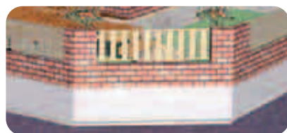
【外壁同タイル貼り】
