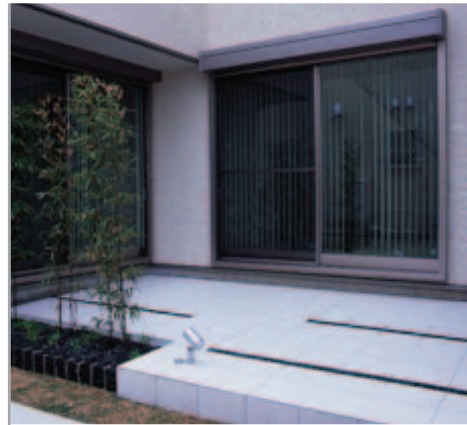
【中庭のテラス】 建物のくぼみ部分に設けたタイル張りのテラス。一部にスリットを入れ、玉砂利を敷いたことで、軽快なイメージに。黒竹は根が他に張らないように、植木鉢ごと埋めてあります。
