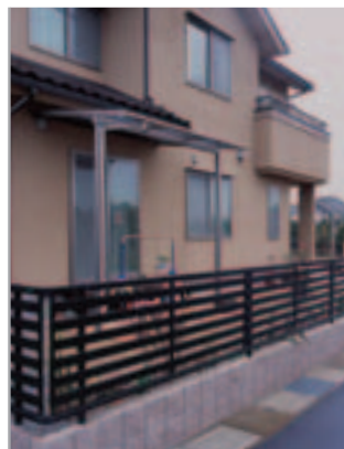
【ルーフバルコニー】 建物の底の下に組み込んだ「グッドエバー」。アーバングレー色が建具の色と同じこともあって、違和感なく溶け込んでいます。これだけでも屋根があればお子さんの遊び場にもなり、なにかと便利。手前のフェンスは「ニューカムフィ」5型を採用。
