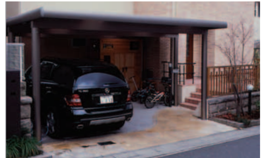
【大型カーポート】 カーポートには「スーパーポートG1」を採用。がっしりと骨太で直線的なフォルムが印象的です。アーバングレー色のために重く感じることなく、建物とも自然に調和しています。
