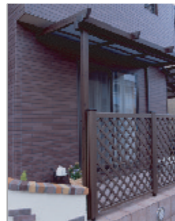
【テラス】 ベランダ園芸を楽しみたいと、掃き出し窓の前にタイルデッキを。デッキの屋根は「ナチュラルテラス」を採用。
