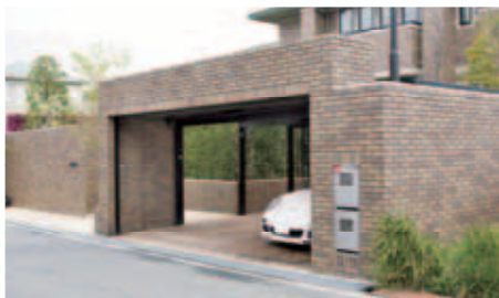
[エクステリア全景] 建物の外壁と同じタイルを塀やシャッターゲートにも使用。すみずみまで統一感があり、重厚で風格のあるエクステリアに。
