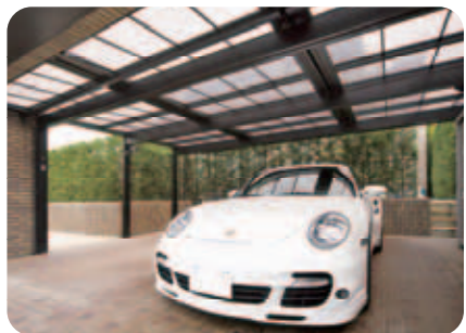
[シャッターゲート内部] Uスタイルをびったりとはめこんだシャッターゲート。Uスタイルだから敷地への納まりもよく、半透明の屋根で明るさも十分。左側の通路は門～玄関アプローチへ、右奥の階段は勝手口へ。
