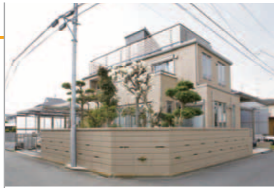
【エクステリア全景】 敷地の対角線上に2つのカースペースを設置。玄関（写真の右側）にはM.シェード、庭側（写真の左側）にはU.スタイルがバランスよく納まっています。塀と庭木は既存のものを生かしました。
