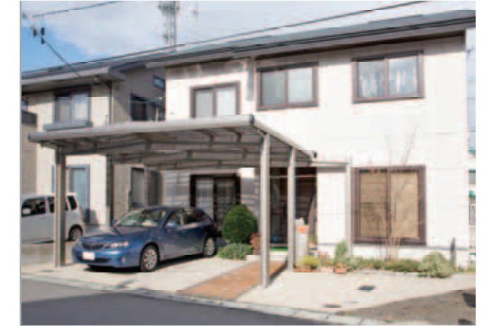
【エクステリア全景】 駐車スペースとアプローチをスノースターのひとつ屋根で覆ったプラン。玄関前は梁を延長させて柱をよけているため、アプローチ~玄関の動線もスムーズです。
