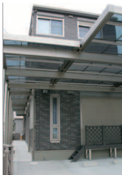
【カーポートから玄関までの通路】 カーポート側から見た通路。床に段差がなく、なだらかな傾斜でスムーズに移動できます。通路の屋根はカーポートの屋根より低くする予定でしたが、同じ高さにしたのでデザイン的にも美しい。
