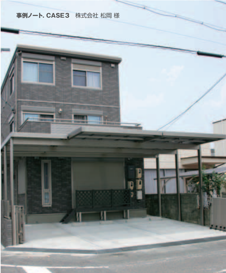
【エクステリア全景】 Uスタイルでカーポートと通路を設置。 Uスタイルのボリュームと建物のバランスがよく、 色もアーバングレーの色調がグレイッシュな建物や サッシの色とびつたり調和して、統一感のある外観に。
