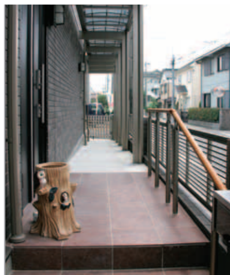
【玄関からカーポートまでの通路】 階段を上った左が玄関。通路の先はカーポート。上にはUスタイルの屋根がかかり、雨の日でも濡れずに移動できます。階段脇の手摺りはエトランポ。
