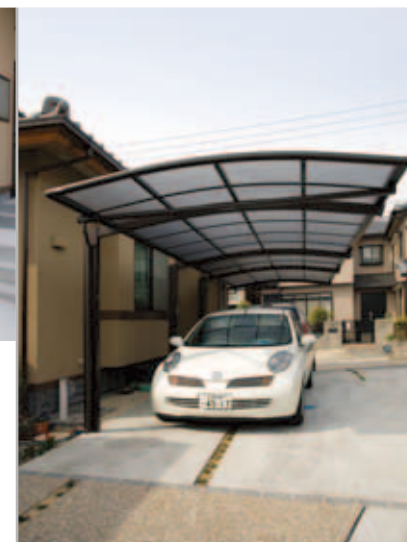
【カムフィネオ】 縦に細長くしか駐車スペースを取れないので、片支持タイプの「カムフィネオ」を奥行き2連結で設置。手前に柱がないので、車の出し入れがスムーズだし、通行のジャマにもなりません。
