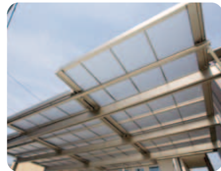
【屋根をずらして設置】 家の前の敷地は右側が斜めにせり出した台形。そのため、「Uスタイル」の屋根をこんなふうにずらして、敷地の形に対応しています。
