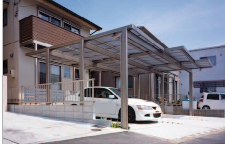
【エクステリア全景】 建物のサッシの色とコーディネートしたUC色の「Uスタイル」。ベージュ系の建物にも自然に溶け込み、統一感のある外観に仕上がっています。大きなカーポートなのに、ライトな色あいで圧迫感を感じさせないのも魅力。
