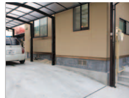
【延長梁で建物の凹凸に対応】 柱を屋根の外側に持ち出せる「延長梁」を使用。建物の凹凸をうまくよけながら、柱を設置できたので、柱にジャマされず駐車スペースが広々と取れました。
