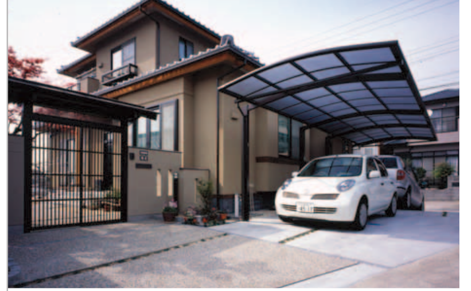
【エクステリア全景】 建物の雰囲気と色に合わせて、門や塀・門扉などを設置。門扉の縦格子は透けるタイプ、塀にはスリット状の窓をあけるなどして、防犯のためにも、外からの視線が入りやすいように工夫。
