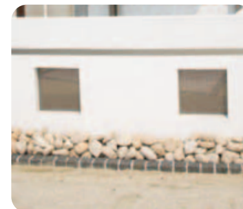
【塀のディテール】 窓にはハンヨウ部材のアルミ板（パンチング）を、横のラインにはハンヨウ部材のフラットバーを使用。床は黒みかげのピンコロでフチ取り、砂利を入れて斬新な和を表現。
