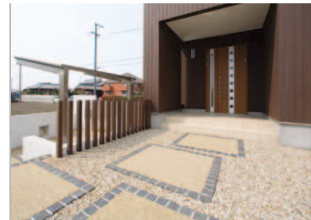
【玄関アプローチ】 門扉から入り、階段を上がったところ。玄関までの道をリズミカルな飛び石デザインで演出。ピンコロのフチ取りがきいています。外壁の板張り合わせた縦格子が、道からの視線をさりげなく遮断。
