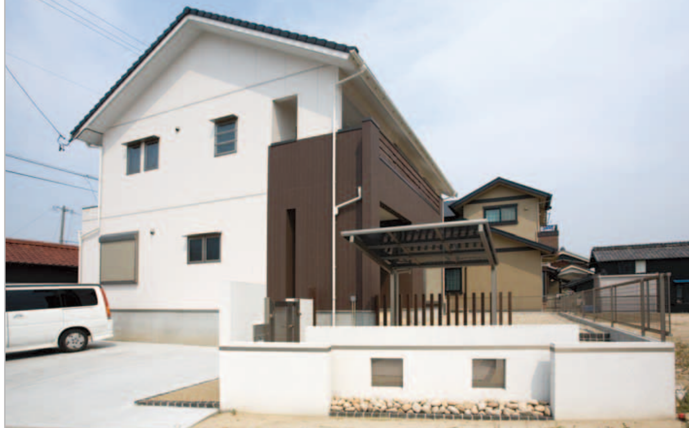
【エクステリア全景】 和モダンの建物に合わせた、シンプルで直線的なエクステリア。塀の白色やサイクルポートのアーバングレイ色が、建物の外壁やサッシの色と見事にコーディネートしています。
