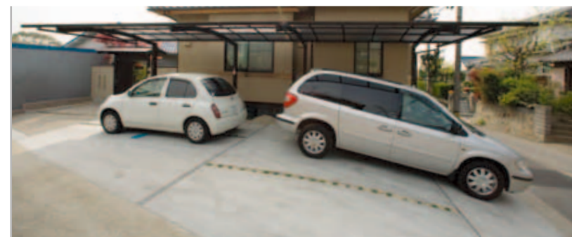
【横から見たカーポート】 こうして見ると、かなり勾配のきつい敷地だとわかります。「カムフィネオ」には高さ2800mmまで可能なロング柱があるので、道路側の柱にはそのロング柱を使用。
