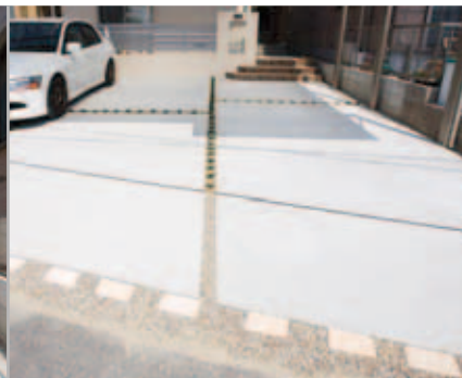
【カーポートの床】 床はコンクリートですが、抜き目地で車の入る区画をつくり、タマリユウや砂利を入れてアクセントに。手前のレンガは施主様の手作業。
