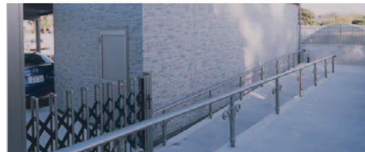
【スロープのアプローチ】 左の駐車場の奥にはスロープを設置。車から降り、カーテンゲートから入って、このスロープを使えば庭に入れます。高齢のご両親を配慮したやさしい設計。カーテンゲートは「エアリーナ」、手すりは「エトランポ」を採用。
