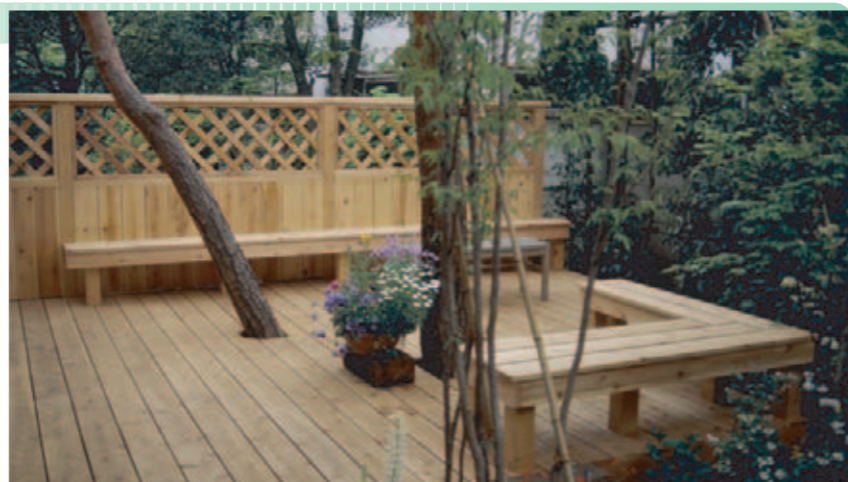
奥は隣家なので間仕切りフェンスを設置。ただし高さを140cmに抑えたので、木々の借景も楽しみつつ、ベンチに座れば視線も遮れます。床を切って松の木を残したので、木陰ができて夏も涼しく、「ベンチでごろ寝」は最高だとか。
