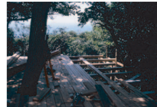
デッキの施工中。斜面の上に建てているので、足下の柱の高さは最長5mにもなり、かなり大がかりな工事に。
