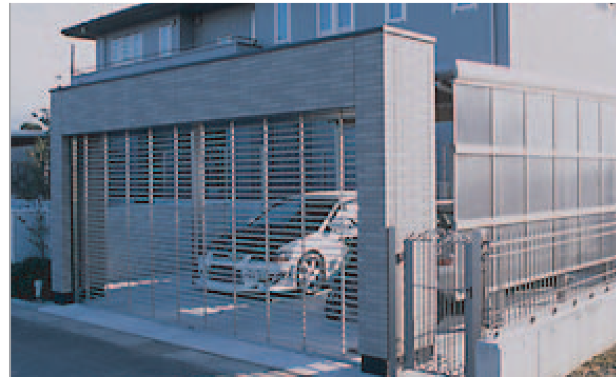
【右側のカーポート】 こちらの「スーパーポートG-1」には、とくにお気に入りの2台を駐車。防犯のため脇に側面パネル、前面にはシャッターゲート「パレオS型」を付けました。カーポート脇の勝手口の門扉とフェンスは「キャスモア」を採用。ここから直接庭に行けます。
