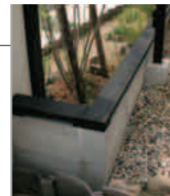
【ブロック塀の笠木】 ブロック塀の上にはデッキの廃材を利用して、笠木ふう。こうするとブロック塀もチープに見えず、ナチュラルで落ち着いた雰囲気のお庭に変身。
