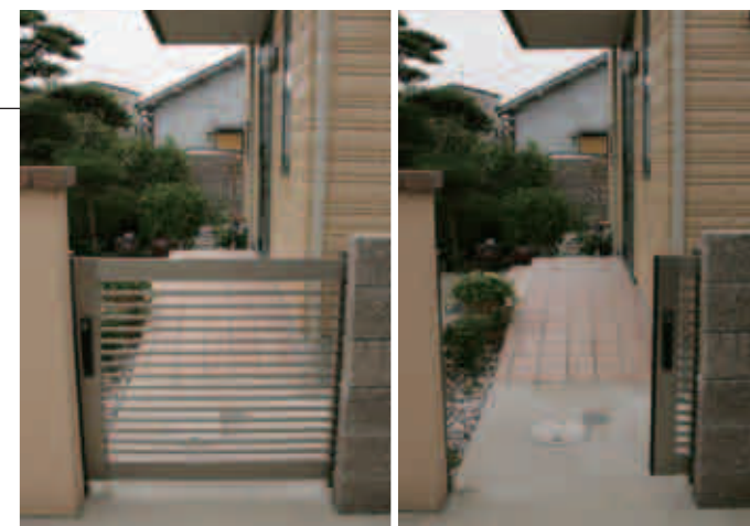
【バリアフリーのアプローチ】 駐車場脇の門から玄関までのアプローチは、段差なしのスロープになっています。スライド門扉「カムフィ1型」は下にレールがなく、車椅子などを使っても引っかかる心配もなし。
