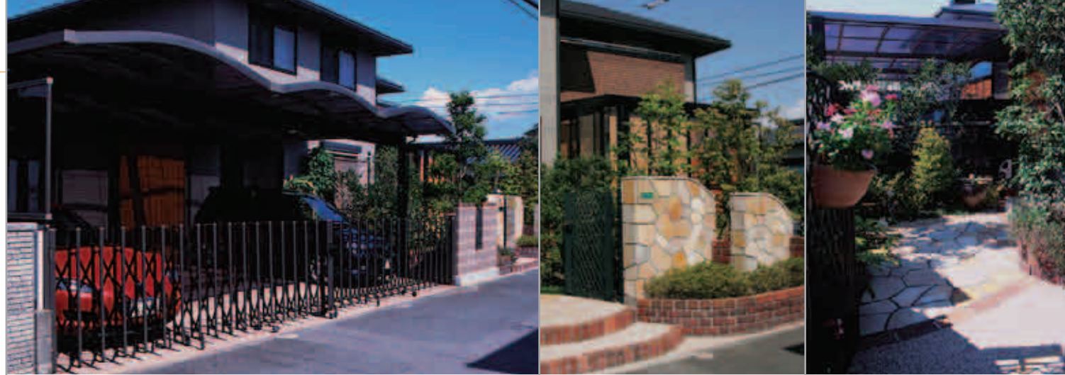
【エクステリア全景・左から】 カーポートは「Uスタイル」。ダイナミックな8m間口で、車3台がゆったり入ります。伸縮式カーテンゲートで長い間口をしっかりとガード。
