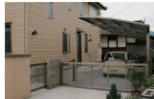
【カーポートとスライド門扉】 カーポートは「カムフィR」、跳ね上げ門扉は「エクモA1型」。
