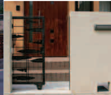
【門まわりの工夫】 スペースのない門まわりに重宝な引き戸の門扉。門柱の下の小窓は、この位置に水道メーターがあるため。こうすれば水道の検針も外からできるし、おしゃれなフポイントにもなり一石二鳥。
