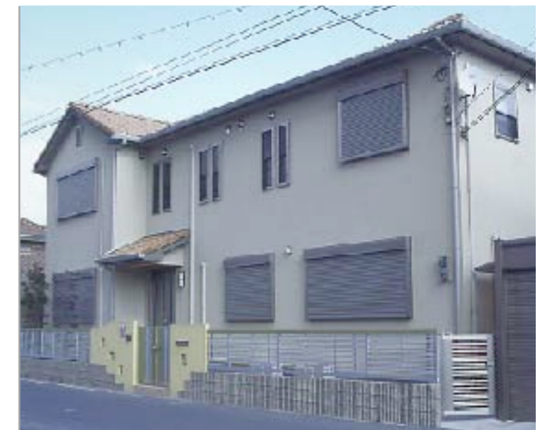
【エクステリア全景】 屋根瓦のオレンジ、壁のライトベージュに合わせ、全体を淡い暖色系にまとめたエクステリア。ご要望通りのクローズ外構ですが、防犯を考え、透けて見える「ラフル」のフェンスを採用。
