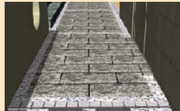
600mm×300mmの御影石を敷き詰めたアプローチ。既存にはこの大きさがなかったので、新たにつくって1枚1枚敷き込みました。黒い目地が効果的で、素材感にリアリティをもたらしています。
