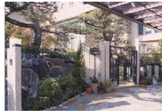
【カーポートから門扉へ】 カーポートの床には、以前石垣に使われていた大きな石などを再利用。床に変化と遊び心。 また、左側の石積みも一部を積み直し、 松も少し位置をずらしてバランスを整えました。
