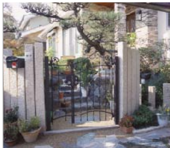
【御影石の門まわり】 門柱は御影石の延石を何本も立てて構成。 高さを変えたり、配置にアールをつけてリズムカルに。 和洋折衷デザインで、洋風の建物と和の庭を調和させています。 右の低い御影石には立水栓を設置。
