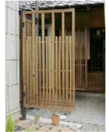
【母屋との境界に格子窓を】 奥にある母屋の玄関とをつなぐ場所には、古い格子窓を扉のように取り付けて、さりげなく目隠し。
