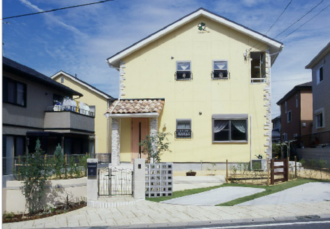
【正面からの全景】 淡いイエローの建物と、オレンジ系の庇、アイボリーベージュの塀や床など、建物とエクステリアの色配分は、一緒にプランしただけに絶妙。高低差を利用して、右側はオープンな駐車場、左側はセミクローズドな塀を設け、視覚に変化をもたらしています。駐車スペースはナナメに取ることで勾配もゆるやかになり、見た目のバランスも美しく、出し入れしやすいと好評です。
