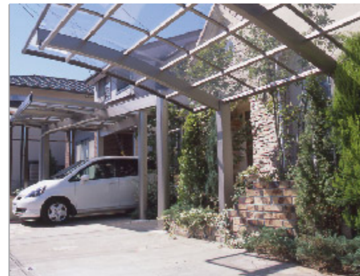
動線を損なわないUスタイルの柱 ] 奥のカーポートは積雪地域向けカーポート「スノースター」。柱を自由な位置に逃がせるため、アプローチの動線や、植え込みを巧みに避けながら柱を設置することができました。また、柱を逃がしたおかげで、3台目の車を中央に駐車することも可能に。
