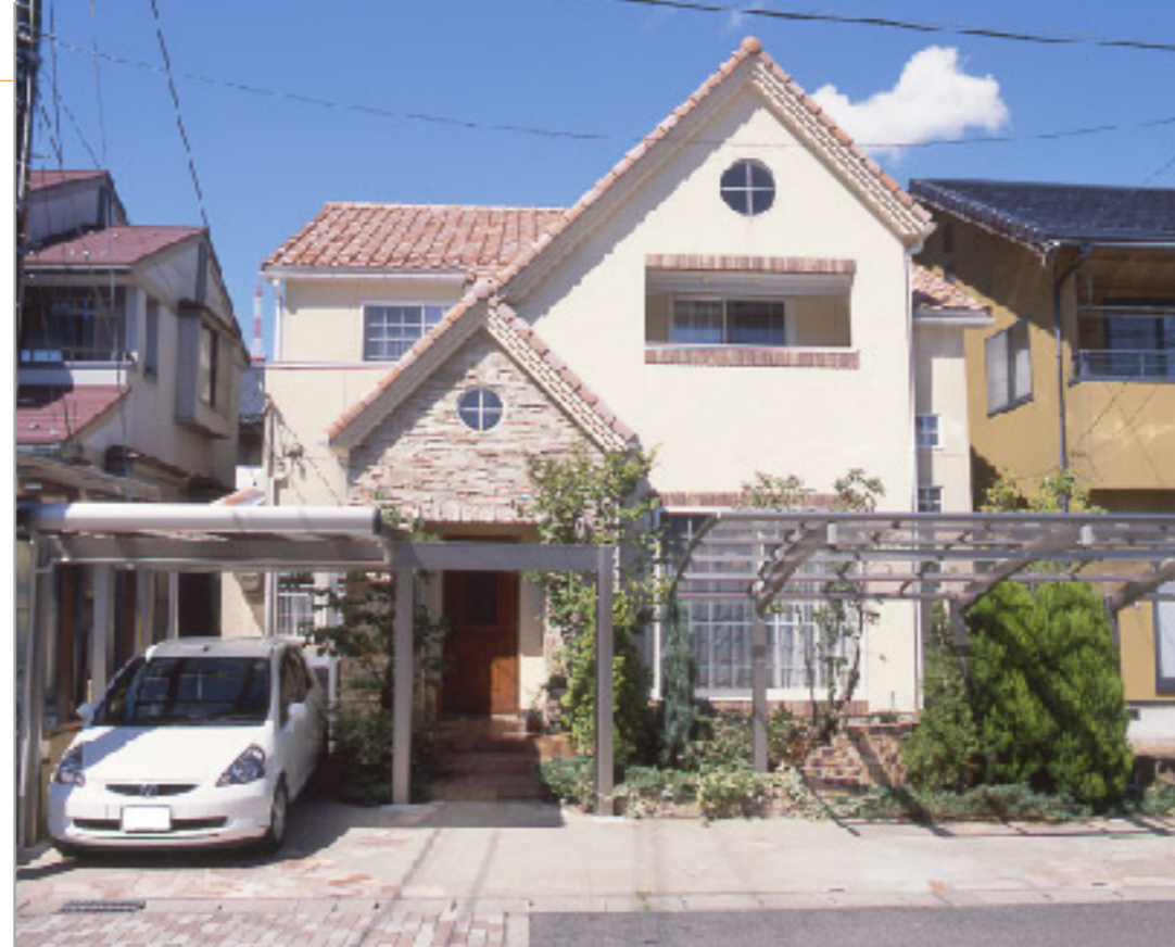
建物&エクステリア全景 ] 左右の2種類のカーポートを後付けしたのですが、どちらもまるで最初からプランニングしたように美しい調和を見せています。 アーバングレーのやさしいメタリック色が、天然素材系の建物外観と自然にマッチ。 高さや分量のバランスも絶妙です。
