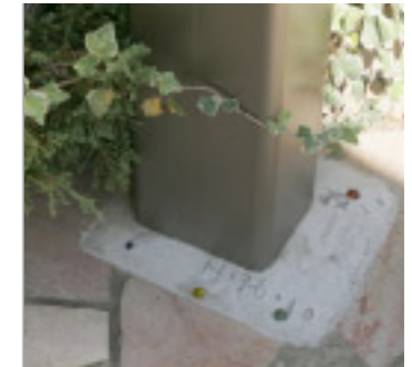
柱の根元は家族の記念スペースに ] カーポートの柱を埋め込んだ根元の部分だけは、後付けなのでどうしても違和感が出てしまいます。それを感じさせないように、ここをお子さんの名前を彫りビー玉を埋め込んで、楽しい記念のスペースに。
