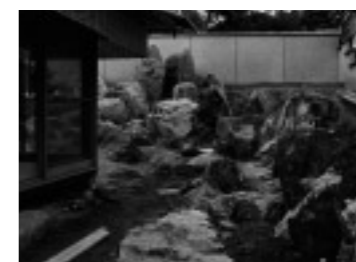
上の写真と同じアンクルの施工中の写真。奥にそそり立った石を組み上げて滝口をつくっているのがわかります。
