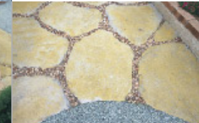
【駐車場の床】 天然石流りに見えますが、実はコンクリートを敷き、手で目地を彫ったもの。低コストで、スタンプよりはるかに見栄えする仕上がりです。
