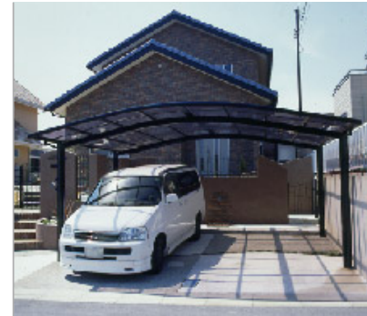
【カーポート】 カムファイRのカーポート。美の立水栓は車を洗うために設置。右奥の出入り口は、朝から直接玄関に行けるので、買い物の荷物が多いときや雨の日も重宝です。
