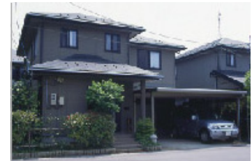
【表の外観全景】 カーポートには100cm積雪対応の「スーパーポートG1」を採用。頑丈な柱と梁、波形のガルバリウム鋼板屋根が、しっかりと雪を受け止めます。色がアーバングレーなので重く感じず、建物ともやさしく調和しています。
