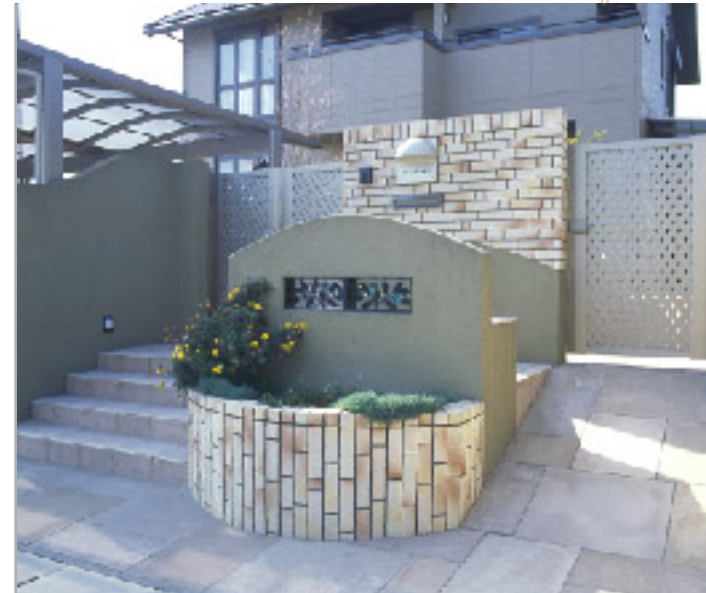
【2つのアプローチ】 左側は階段、右側は便利な自転車のスロープ。床材は、「よそにない素材を」というご要望で、ブラジル産の砂岩を張りました。
