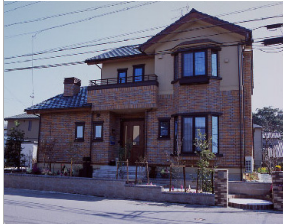
【正面からの全景】 レンガふうタイル張りの風格ある建物。道に面した外構はオープンになっていて、道ゆく人の目を楽しませ、来客を暖かく迎えてくれます。
