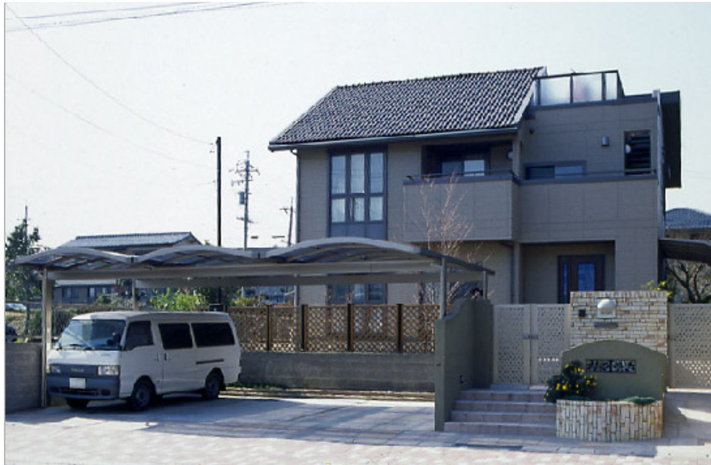
【全景】 モダンな建物と、シンプルでダイナミックな「Uスタイル」の駐車場が見事にマッチ。門扉&アプローチとのバランスも絶妙です。
