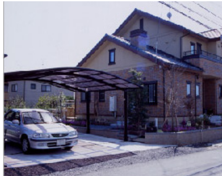
【駐車場側からの全景】 「カムファイR」のダイナミックなアール屋根と重厚な色調が、建物と美しく調和しています。
