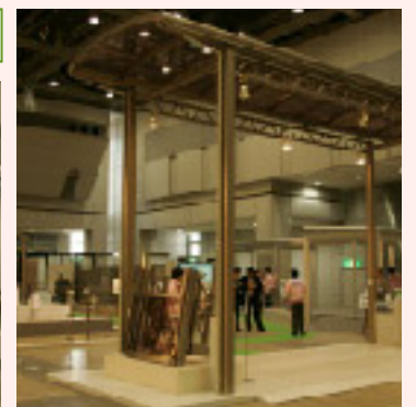
高さ4mなので背の高い消防車も通れる緊急車両通過仕様の通路シェルター。
