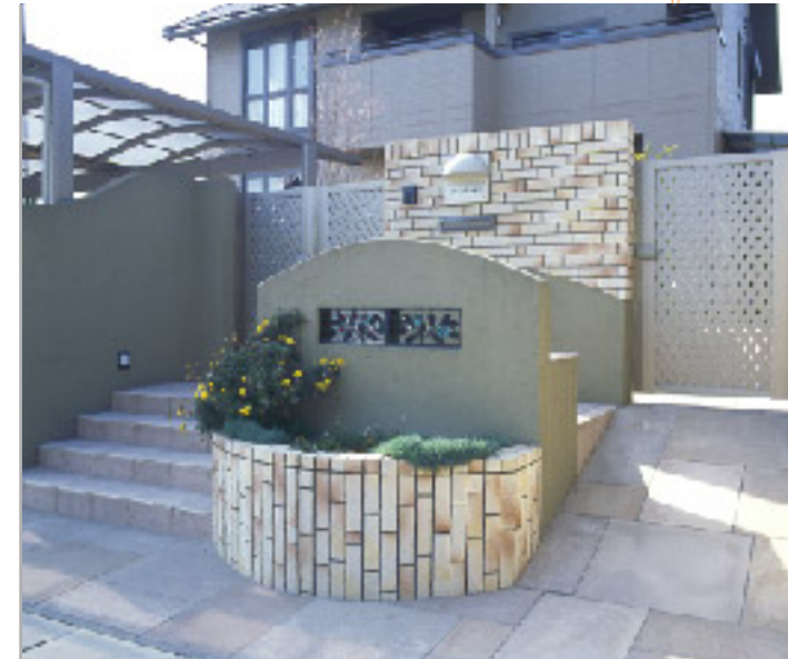
【2つのアプローチ】 左側は階段、右側は便利な自転車用のスロープ。床材は、「よそにない素材を」というご要望で、ブラジル産の砂岩を張りました。
