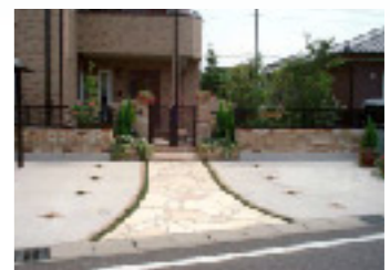
駐車場を兼ねたアプローチ。石を部分的に貼ることで、美しさと予算を両立。
