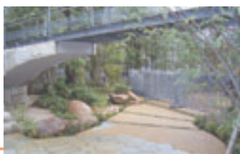
車椅子で庭を回遊するためのスロープ。ブリッジは、管理車両進入時のための跳ね橋であり、構造体であるH鋼のシャープな線はモダンである( N邸 ブリッジ設計:上田徹 )
