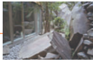
根府川石による石組と石構。 根府川石は従来石碑や沓脱石の 石材として流通していた石だ( N邸 )
