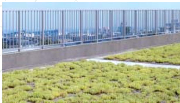
屋上緑化でエコロジーを実践する「未知草」
