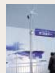
風力発電による照明灯
