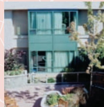
居室の窓からは、かならず中庭が森が見えるように設計されているカナダの高齢者長期療養施設。
